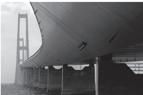
写真 - 15 グレートベルト・イースト橋
