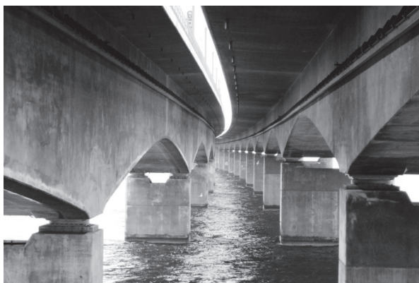
写真 - 19 バケット取付け用レール
