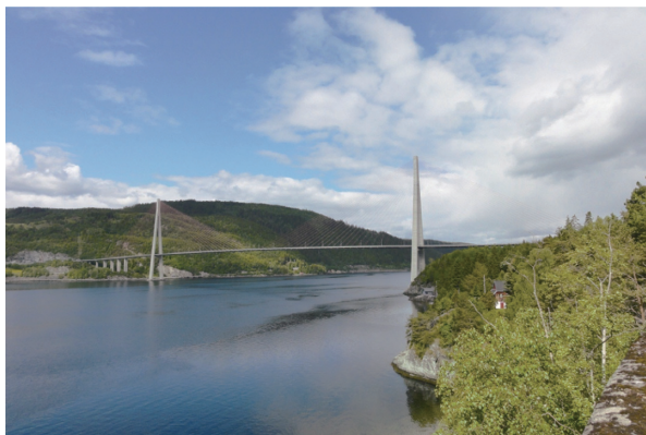
写真 - 9 スカルスンド橋
