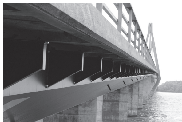
写真 - 21 鋼製ブラケットに支持されるプレキャスト床版
