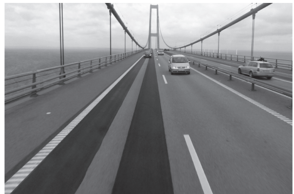
写真 - 17 イースト橋の舗装
