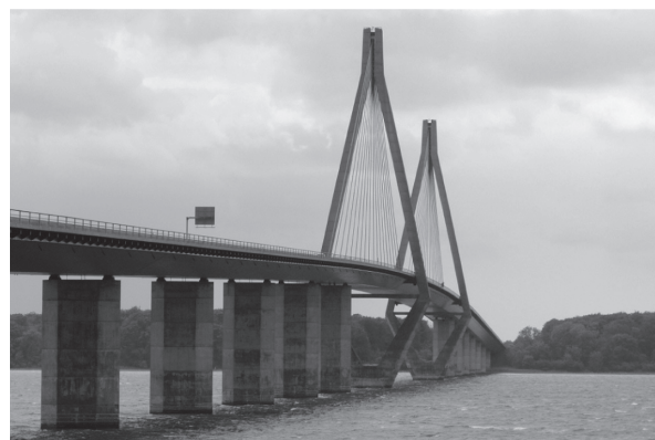
写真 - 20 ファロー橋（全景）
