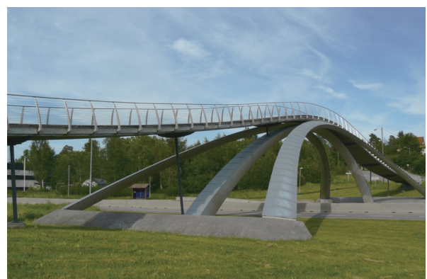
写真 - 12 レオナルド橋
