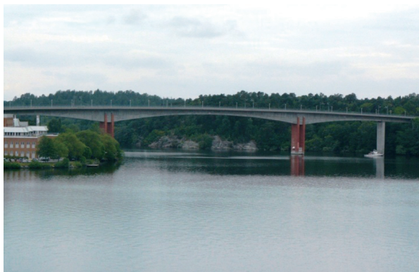
写真 - 5 アルピック橋
