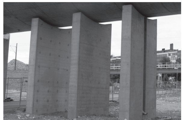
写真 - 4 構造上の機能をもたない橋脚
