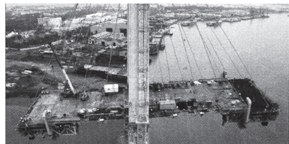
図-9 主桁の張出し架設
