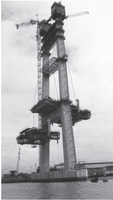
図 - 6 主塔の施工
