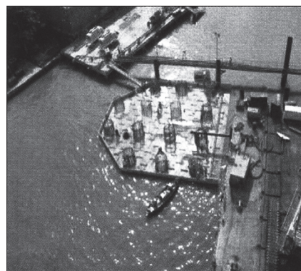
図 - 3 主橋脚の杭配置とプレキャスト型枠
