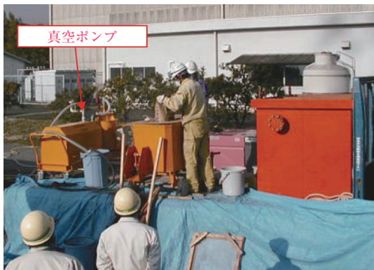
写真 - 4 真空ポンプの併用
