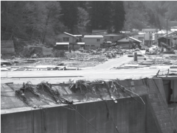
写真 - 5 架橋地点下流 1 km 小本川水門周辺の状況
