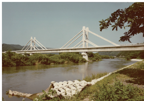
写真-1 小本川橋梁全景
