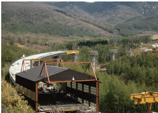
写真 - 2 押し出し架設状況
