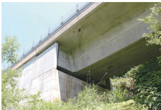
写真 - 5 A 2 橋台支点部の状況
