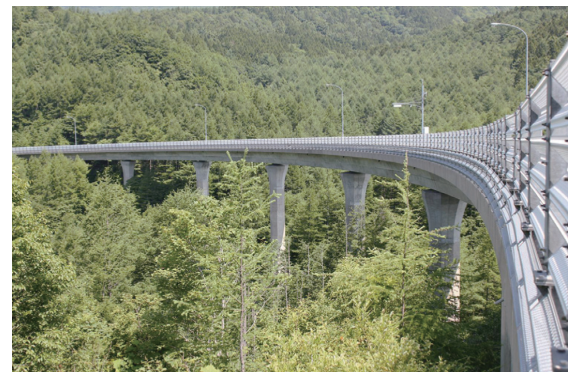
写真 - 3 A 1 橋台からA 2 橋台方向を望む
