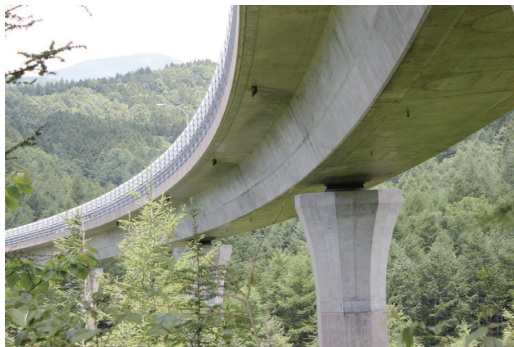
写真 - 6 P 1 橋脚付近の外観と排水処理
