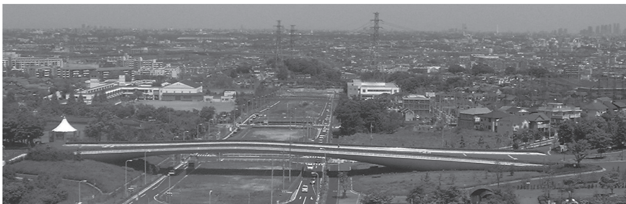
写真 - 1 くじら橋
