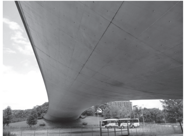
写真 - 5 桁下全景（A1側より撮影）
