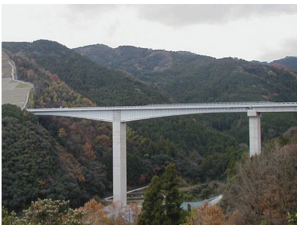
写真 - 4 小河内川橋
