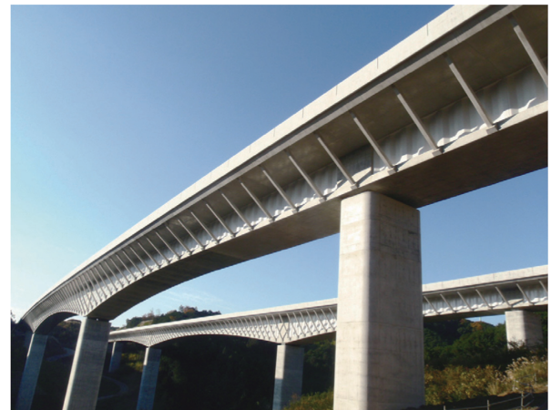
写真 - 6 谷津川橋
