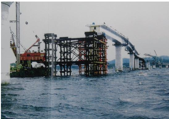
写真 - 6 側径間支保工の架設状況
