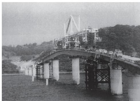
写真 - 4 ローチングガーダーの航路部移動状況
