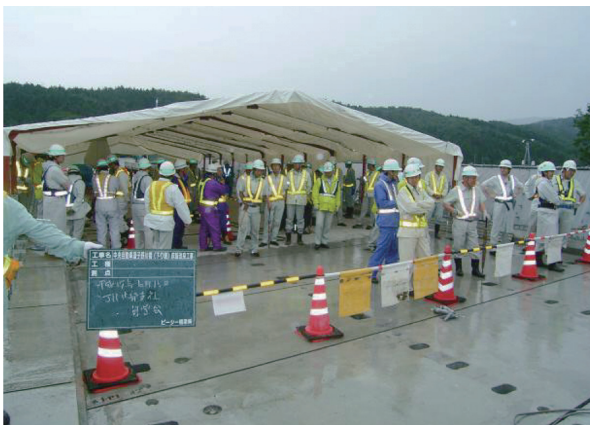
写真 - 2 作業上屋の設置
