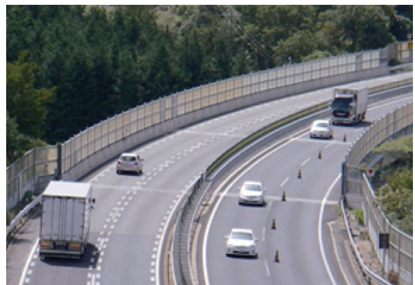
写真 - 5 子野川橋の全景
