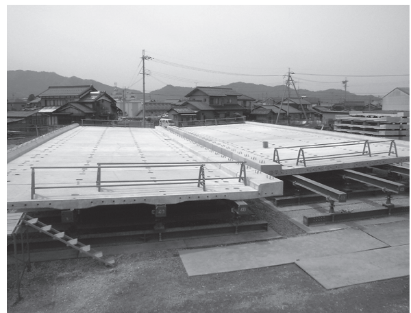
写真 - 1 仮組み後の PC 床版
