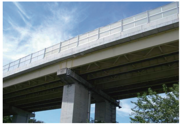
写真 - 3 子野川橋の側面
