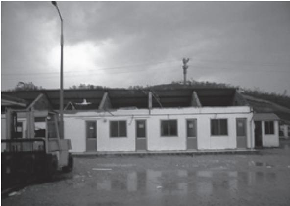
写真-3 屋根が吹き飛ばされた作業事務所
