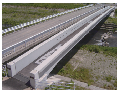
写真 - 1 曳田歩道橋全景（竣工後）
