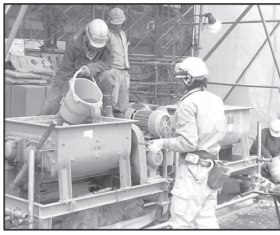
写真 - 4 場所打ち UFC の練混ぜ状況
