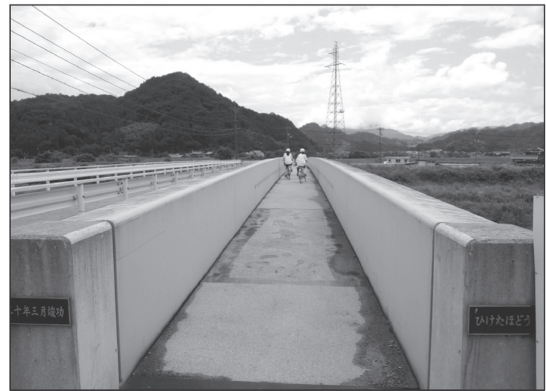
写真 - 6 曳田歩道橋現状 (竣工 5 年後)
