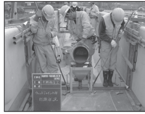
写真 - 5 場所打ち UFC の打込み状況
