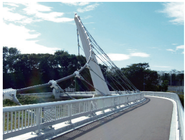
写真 - 5 橋面からタワーの景観
