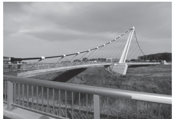
写真 - 10 境川右岸からの景観
