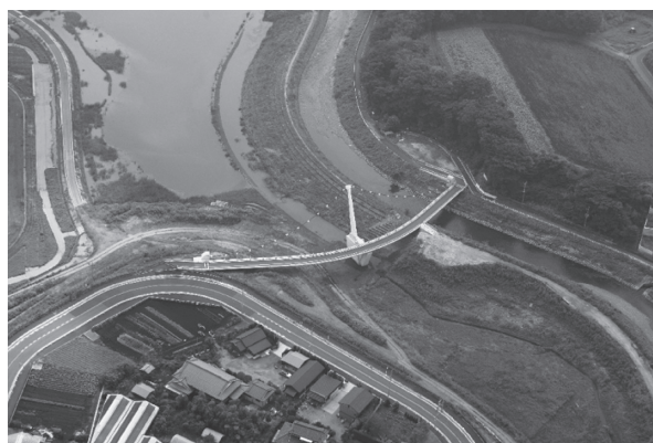
写真 - 1 鷺舞橋の航空写真
