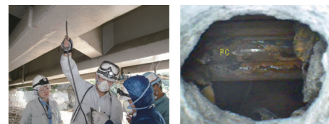
写真-3 PCグラウト調査状況
