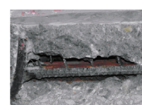
写真 - 2 PC鋼線腐食状況
