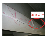
写真 - 1 主桁再劣化状況
