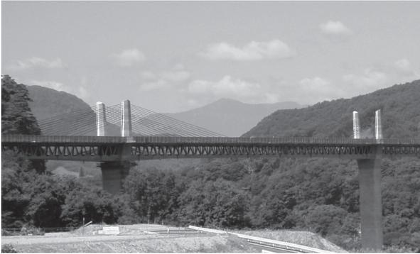
写真 - 2 エクストラロード橋の例
