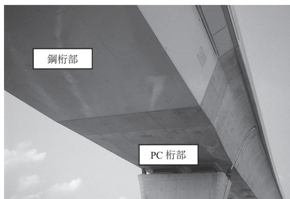
写真 - 1 混合桁橋の接合部の例
