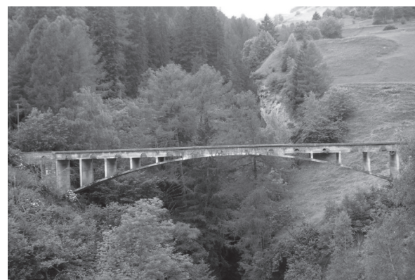
写真 - 3 下流側中央からのウアルチール橋
