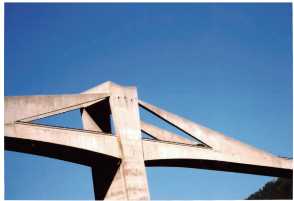
写真 - 13 主塔, 斜材, 主桁および橋脚の一体化
