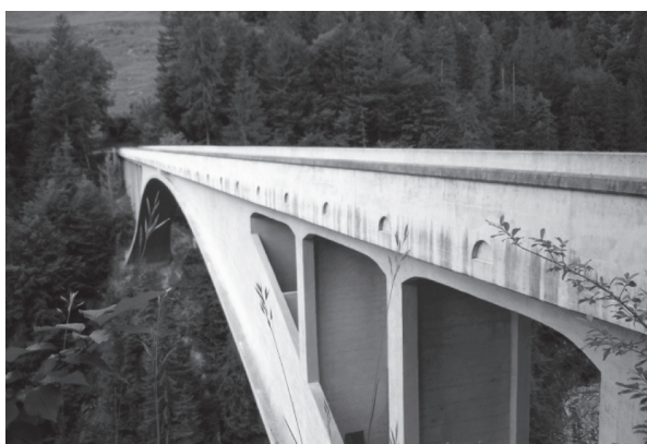
写真 - 10 サルギナトobel橋のアーチリブと鉛直壁
