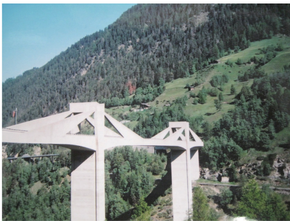
写真 - 12 ガンター (Ganter) 橋の全景
