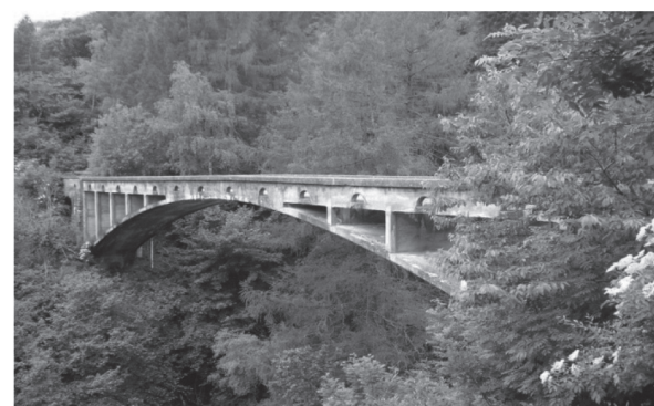
写真 - 4 下流側左岸からのウアルチール橋
