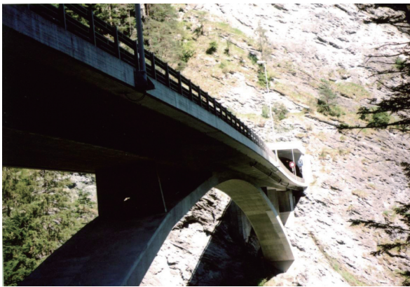
写真 - 11 ヴィア マラ (Via Mala) 橋の薄いアーチリブと補剛桁
