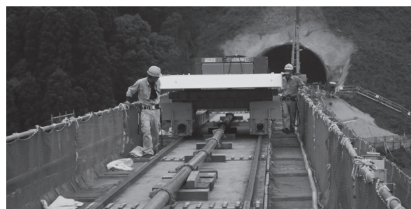
(a) 架設桁上の運搬状況
