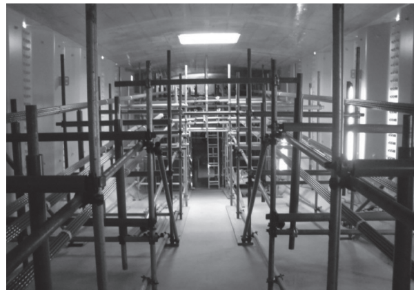
写真 - 5 PC 鋼材緊張完了後の全景
