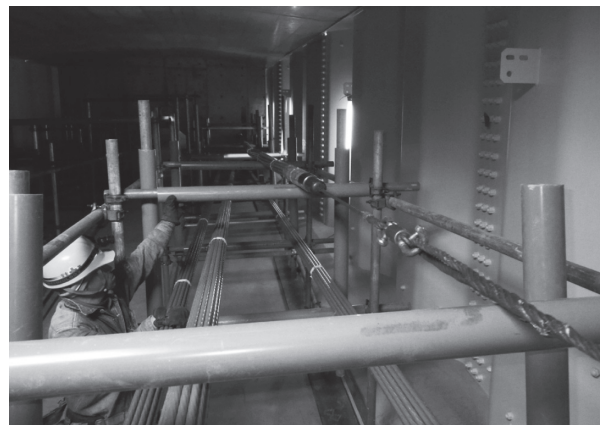
写真 - 4 PC 鋼材挿入状況
