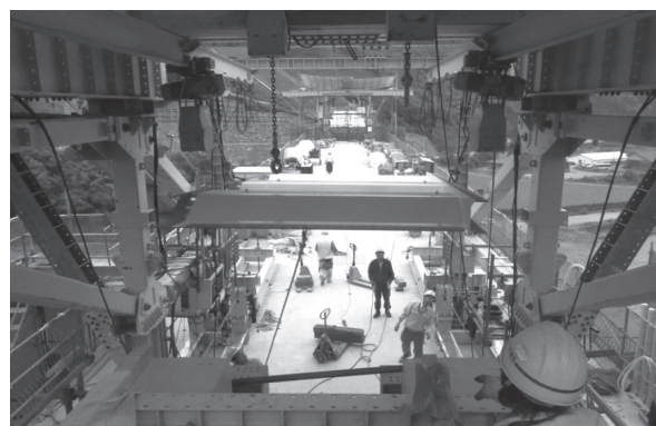
(b) 移動作業車による吊込み状況
