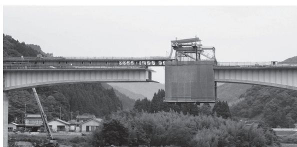
(b) 架設桁施工時近景
