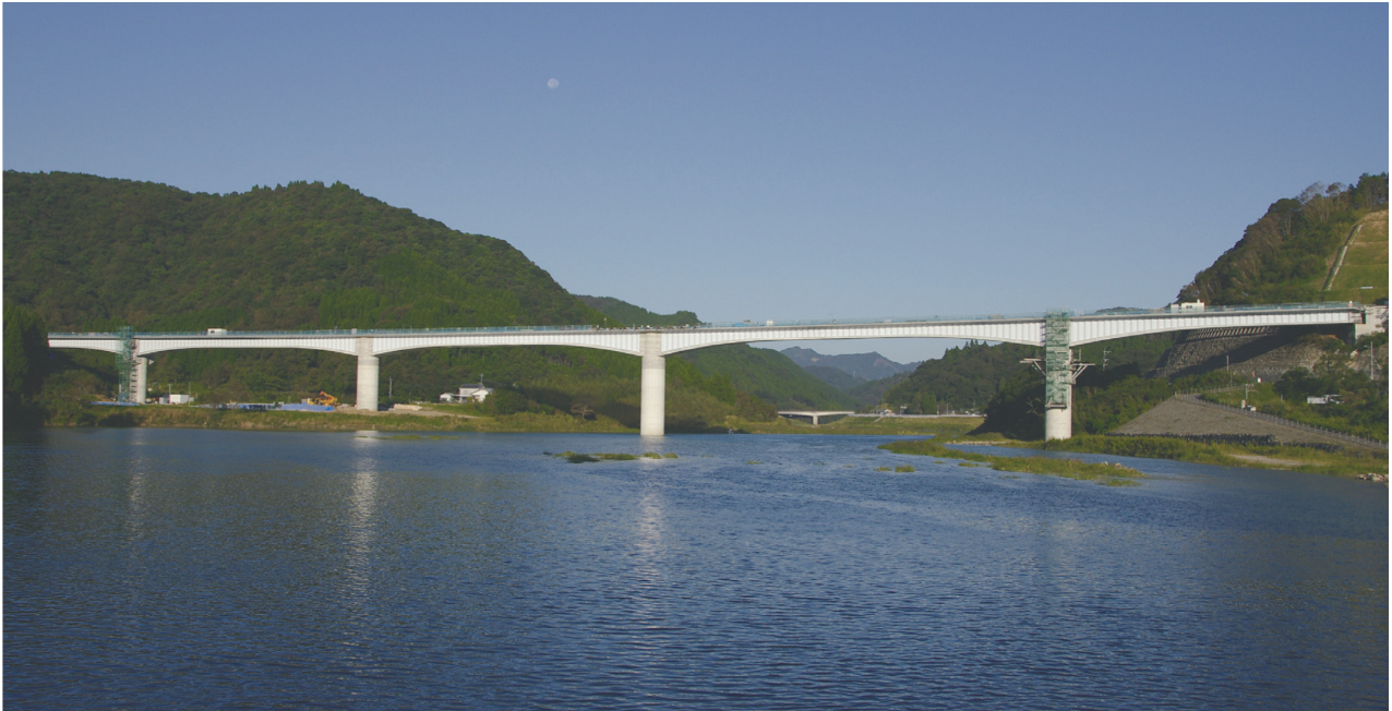
写真 - 7 橋体工施工完了（下流側より望む）
