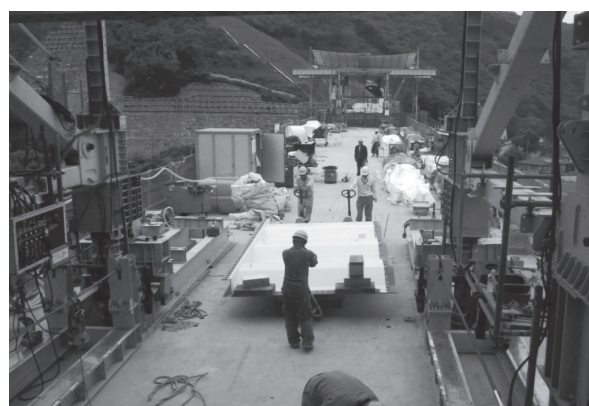
(c) 橋面上の横持ち運搬状況
