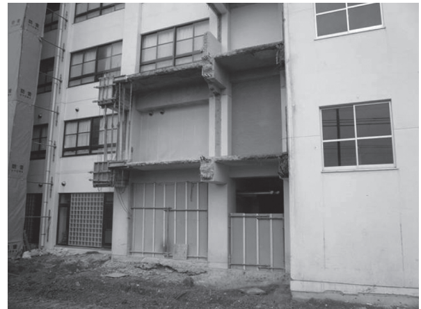
写真 - 4 解体後の状況
