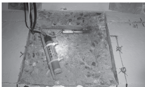
写真 - 3 照合電極の設置状況
