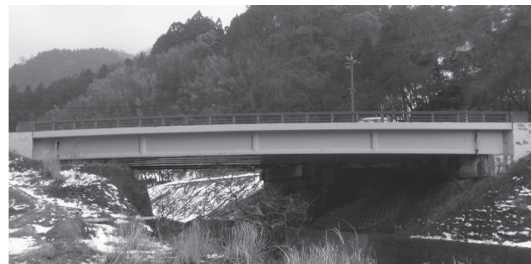
写真 - 1 橋梁の概要
