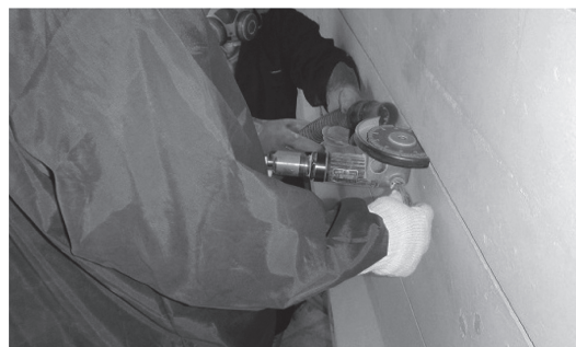
写真 - 6 溝切削状況
