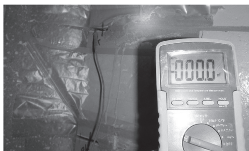
写真 - 11 陽極間導通確認状況
