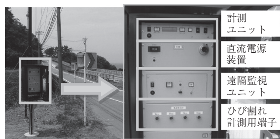
写真 - 12 直流電源装置設置状況
