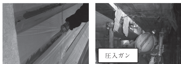
(a) 桁側面 (b) 桁底面
