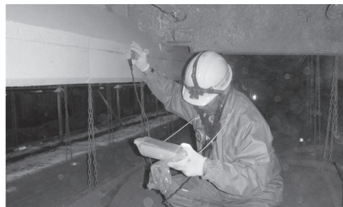
写真 - 5 鋼材かぶりの確認状況
