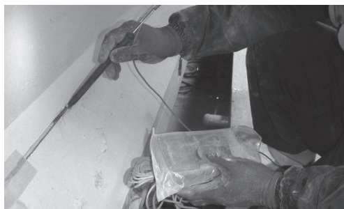
写真 - 7 露出金属探査状況
