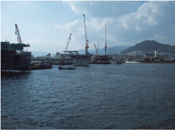
写真 - 1 太田川橋りょう施工状況
