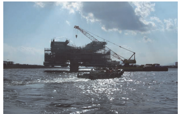
写真 - 3 通船でのP1橋脚クレーン台船への移動
