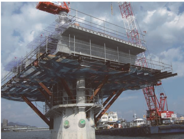
写真 - 5 P3 橋脚の柱頭部ブラケット
