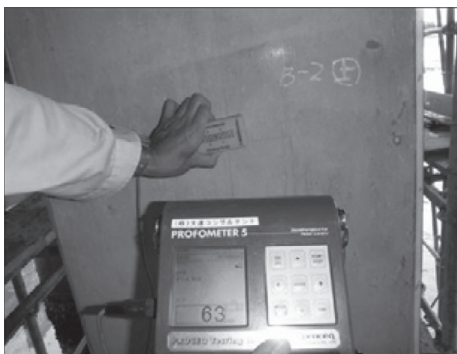
写真 - 2 鉄筋かぶり測定状況
