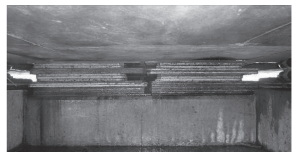
写真-7 安全装置用鋼板設置状況
