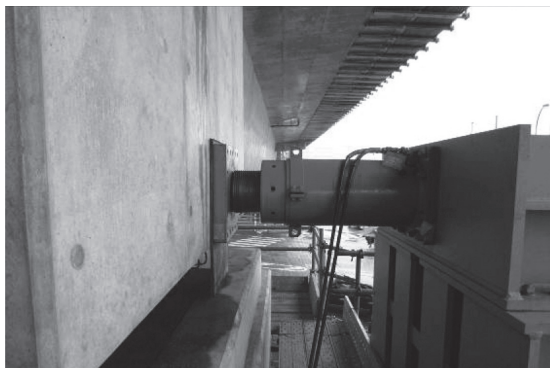
写真 - 8 水平移動防止ジャッキ設置
