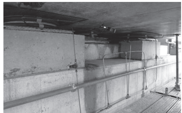
写真-6 連動配管状況
