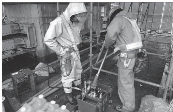
写真 - 9 不凍液の注入状況
