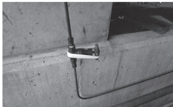
写真 - 10 ストップバルブの養生状況
