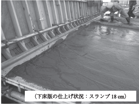
写真 - 3 打設試験状況
