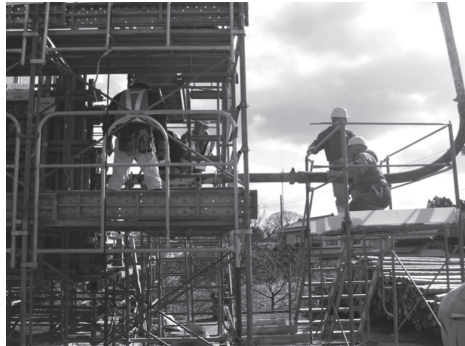
写真 - 3 妻型枠開口打設状況
