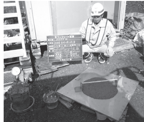
写真 - 1 高流動コンクリートのスランプフロー試験状況
