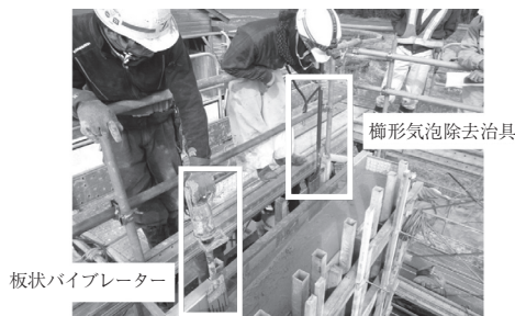
写真 - 6 ウェブ側面仕上げ状況
