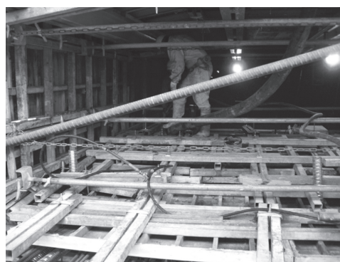
写真-5 下床版打設状況
