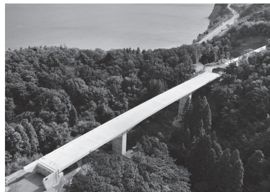
写真 - 8 架設完了全景
