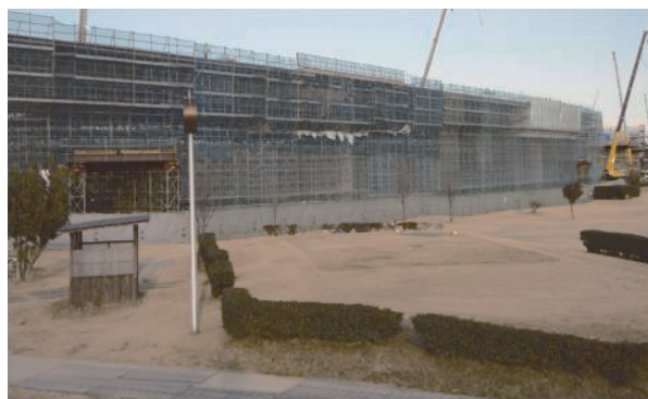
(a) 固定支保工を用いた架設工法 (利根川橋)
