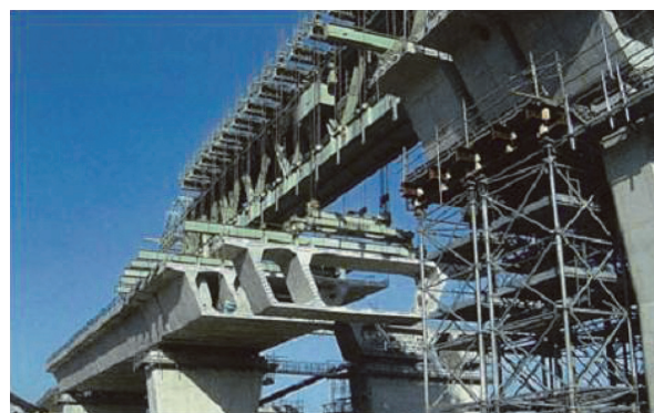
写真 - 2 プレキャストセグメントの架設 1) (鍋田高架橋)
