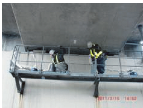
写真 - 4 ひび割れ部への無収縮モルタル注入
