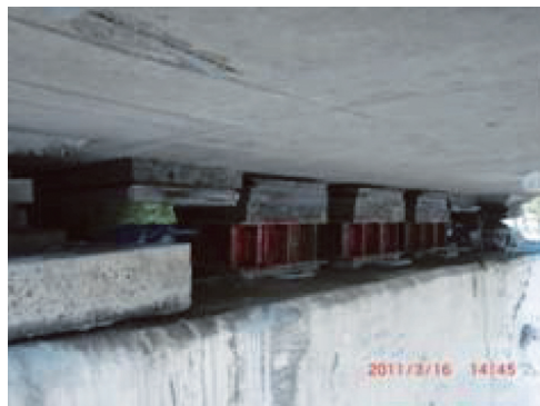
写真 - 3 ジャッキおよび仮受け鋼材
