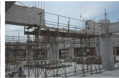
中間 PCa ブロック梁の架設
