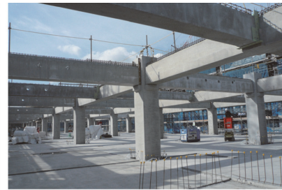
PCa 小梁の架設
