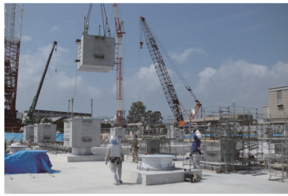
免震ブロック架設
