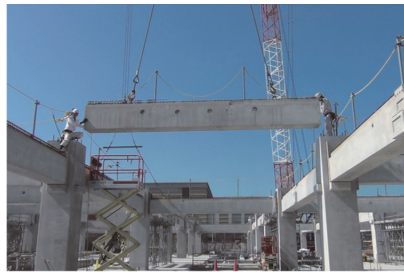
PCa 大梁の架設
