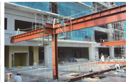
鉄骨造の架構
