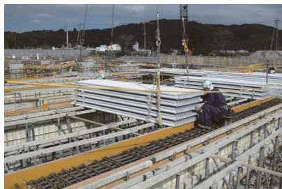
PCa 床版の架設
