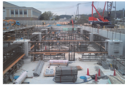
1階 RC 梁の配筋
