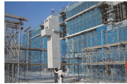
1階 PCa 柱の架設
