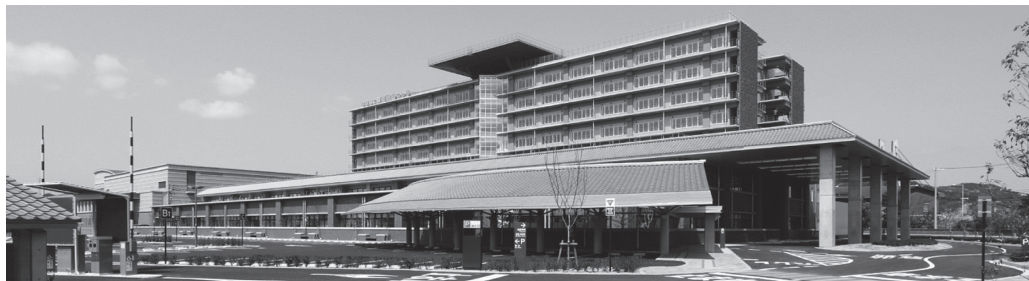
写真 - 2 建物全景 (南面)*1
