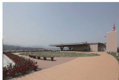
高層部 屋上庭園
