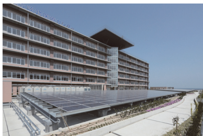
低層部 屋上太陽光パネル
