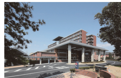
エントランス大庇
