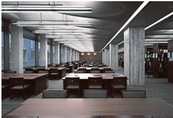
写真 - 4 梁一体型曲面 PC 床版
