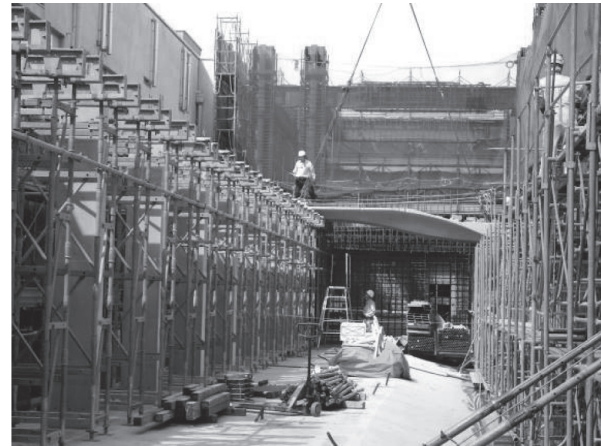
写真 - 12 ST システム支保工
