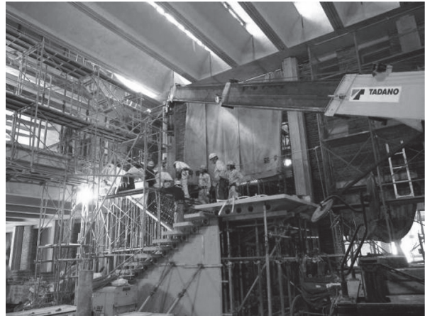
写真 - 17 PCa階段の建方
