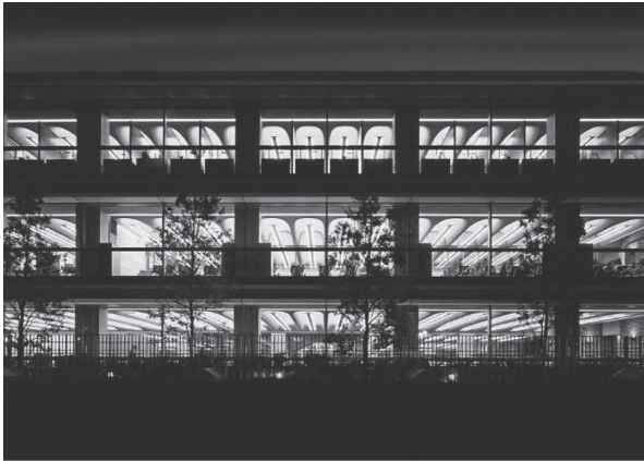
写真 - 2 外観写真
