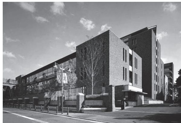
写真 - 1 全景写真
