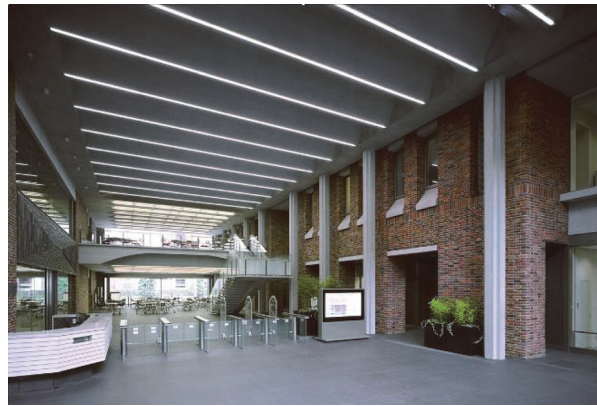
写真 - 5 エントランス部 r 型曲面 PC 床版
