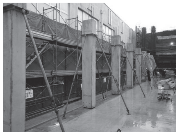
写真 - 14 PC6 建方
