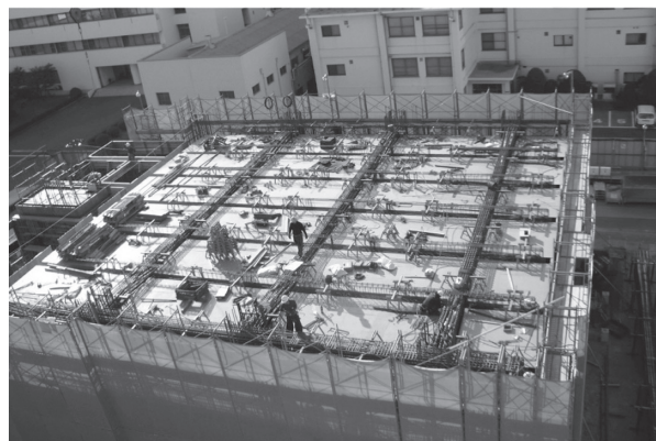
写真 - 11 PRC 大梁配筋状況
