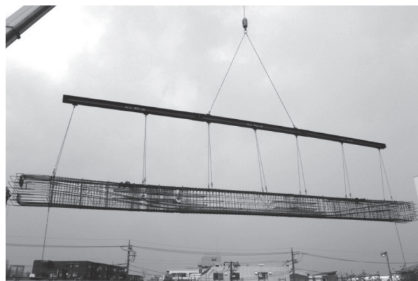
写真 - 10 PRC 大梁配筋状況
