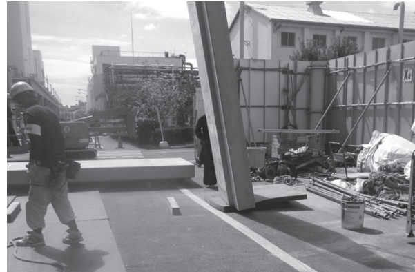
写真 - 5 PCa 柱建方状況
