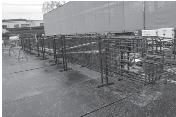
写真 - 9 PRC 大梁配筋状況
