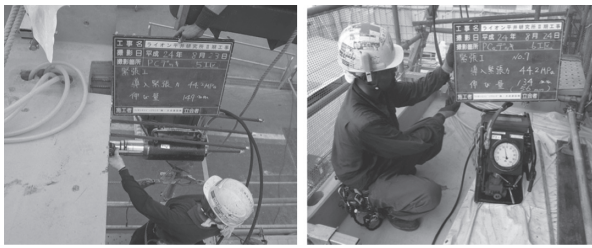
写真 - 7 緊張作業状況
