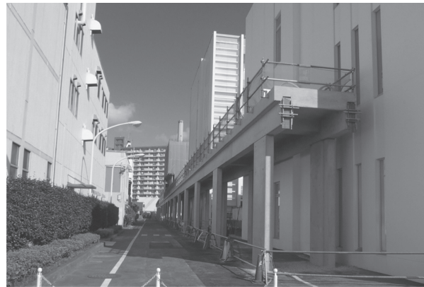
写真 - 8 PCa 建方工事完了
