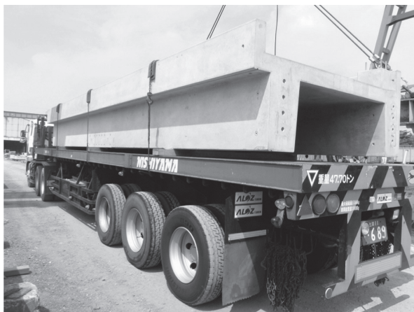
写真 - 4 PCa 床梁運搬状況
