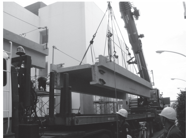
写真 - 6 PCa 床梁建方状況
