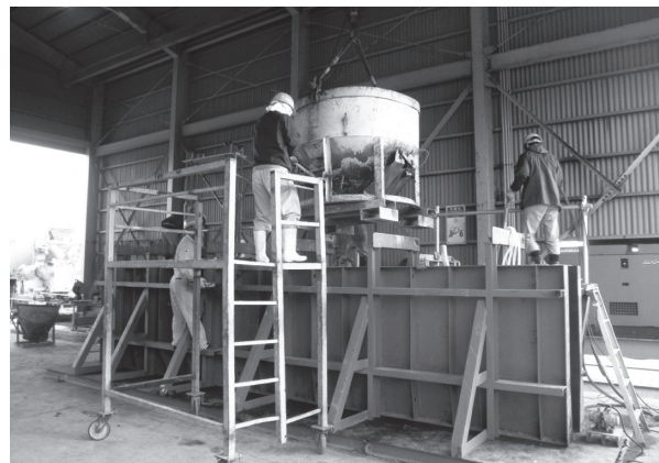
写真 - 16 コンクリート打設状況
