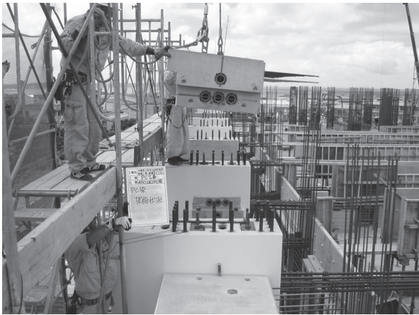
写真 - 13 PCa大梁架設状況（コーベル上に架設）
