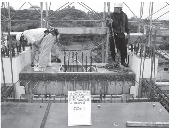
写真 - 15 スラブ打設部分の粗面仕上げ状況
