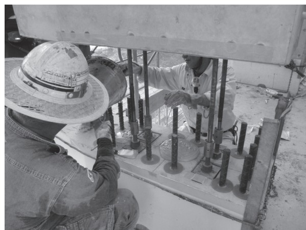
写真 - 12 柱建方状況2 (接着剤の塗布)
