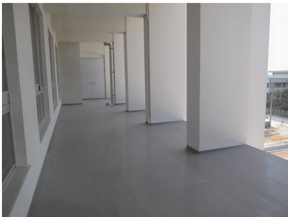
写真 - 6 柱ルーバー (病室から撮影)
