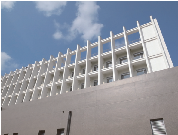
写真 - 4 建物外観 (南方向より撮影)
