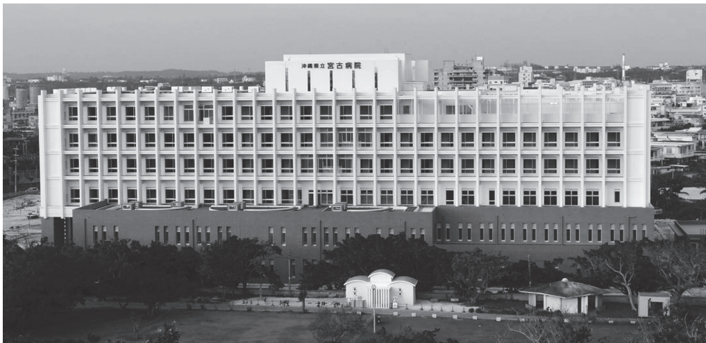
写真 - 1 建物全景（カママ嶺公園より撮影）
