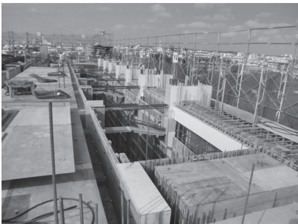
写真 - 14 建物内部の現場打ち，外周は工場生産
