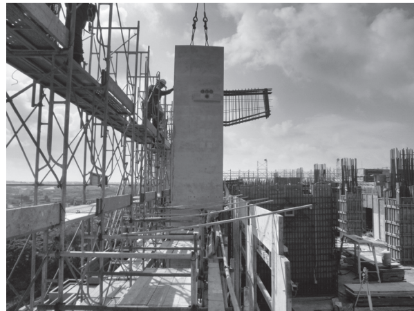
写真 - 11 柱建方状況1 (柱の建込み)
