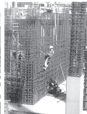
図 - 5 耐震壁の配筋 (Photo©Tipping Mar)
