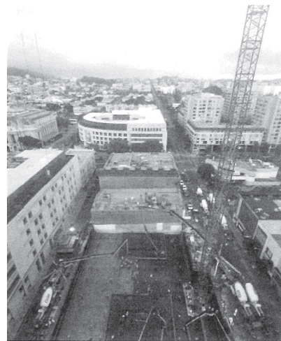
図 - 9 マット基礎の打設 (Photo©SFPUC)
