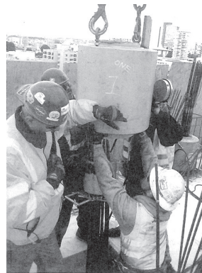
図 - 4 耐震壁の緊張状況 (Photo©Tipping Mar)
