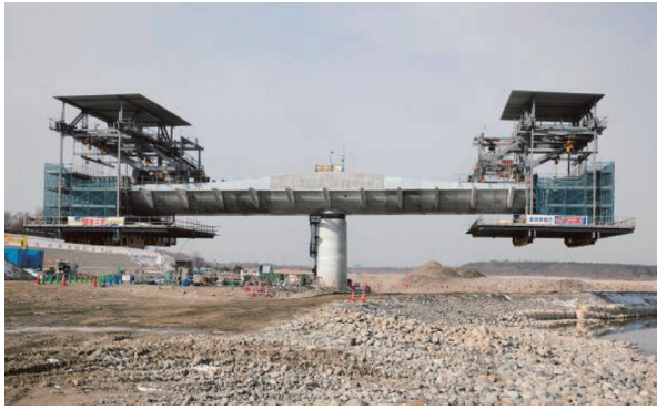
写真 - 7 移動作業車を用いた張出し架設状況 (P9 橋脚)
