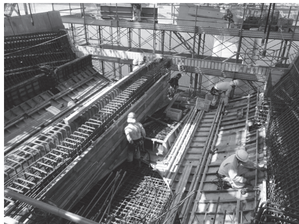
写真 - 6 施工状況 (内枠組立て)
