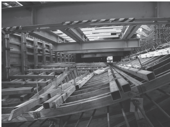
写真 - 3 桁内状況
