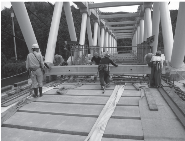
写真 - 4 床版運搬状況
