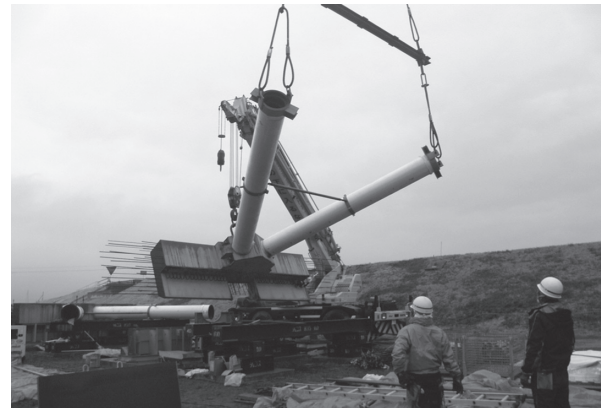
写真 - 3 セグメント回転状況
