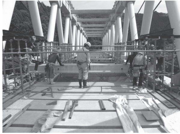
写真 - 5 床版架設状況
