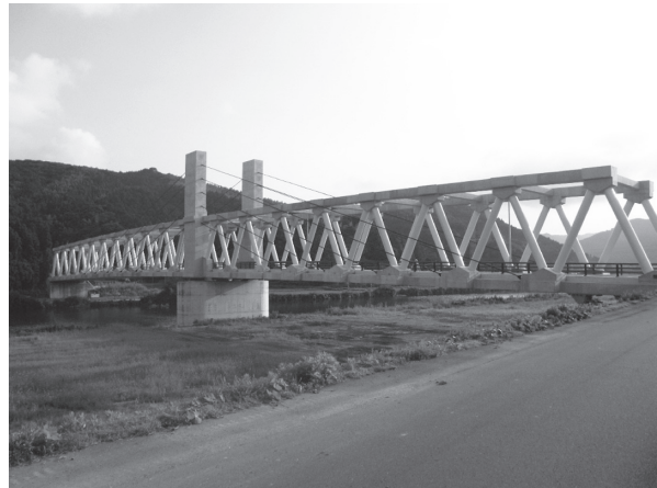
写真 - 6 完成写真
