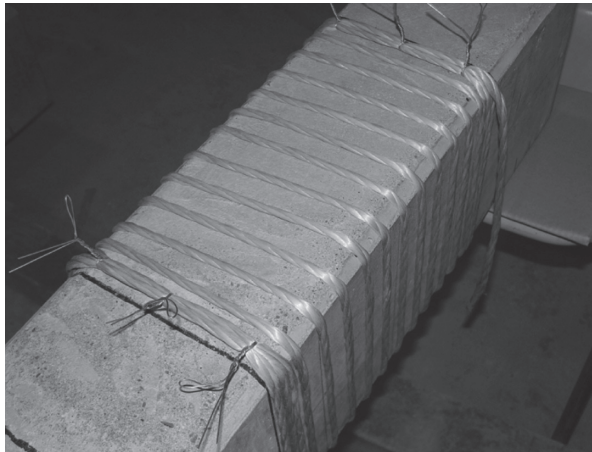
写真 - 2 連続繊維ロープの緊結状況
