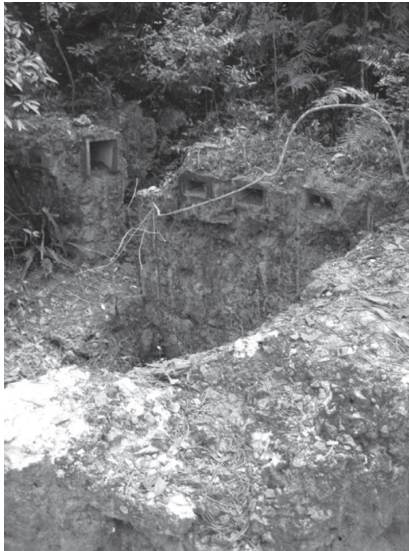
写真 - 23 ライオンロック付近に現存する英国軍が設置したトーチカ
