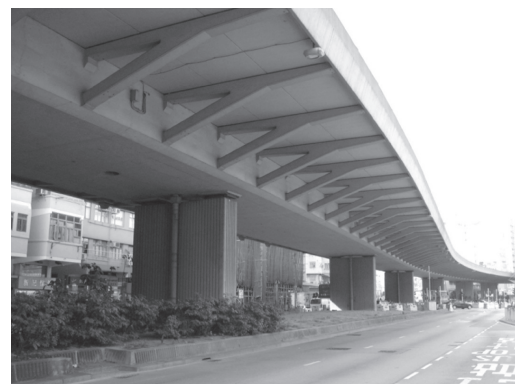
写真 - 17 ストラット付き箱桁による東九龍コリドー
