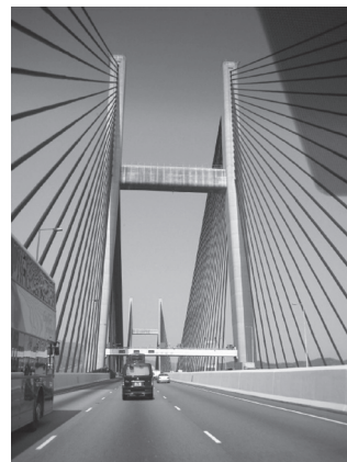
写真 - 7 Kap Shui Mun 橋橋面から
