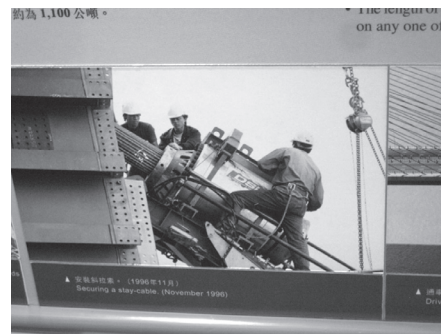
写真 - 8 Kap Shui Mun 橋斜材緊張作業の様子 (Lantau Link Visitors Center にて)
