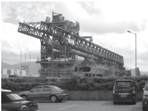
写真 - 19 プレキャスト張出し架設される香港島東コリドー
