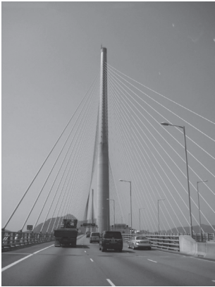
写真 - 3 Stonecutters 橋橋面から
