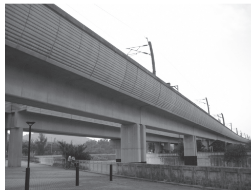
写真 - 16 2枚壁式橋脚の剛結ラーメン鉄道高架橋
