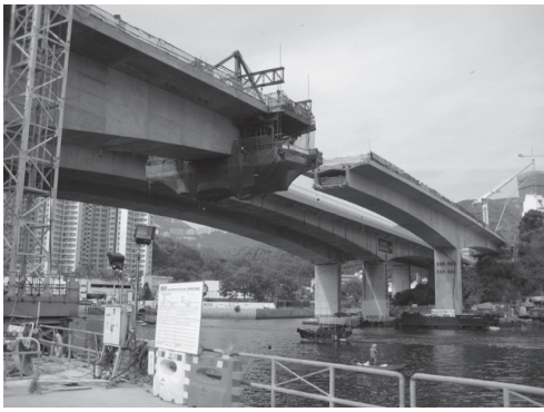
写真 - 18 張出し架設中の MTR 南港島線香港仔海峽橋
