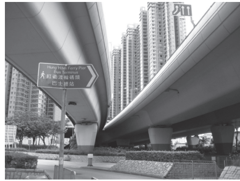
写真 - 15 プレキャストセグメント工法によるホンナムバイパス
