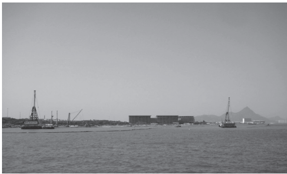
写真 - 14 香港 - マカオ架橋空港島東岸埋立て工事風景
