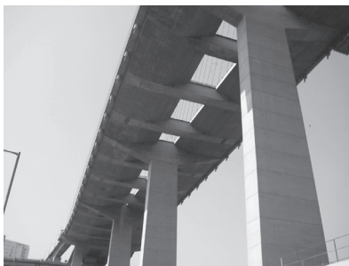
写真 - 4 Stonecutters 橋側径間 PC 桁
