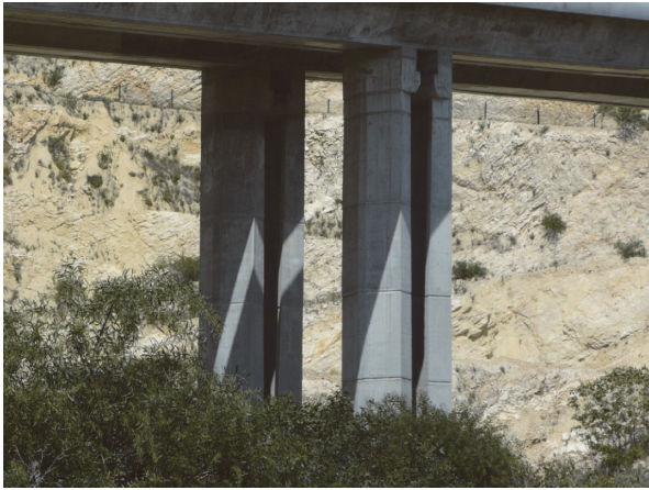
写真 - 11 Quarry Bridge 橋脚
