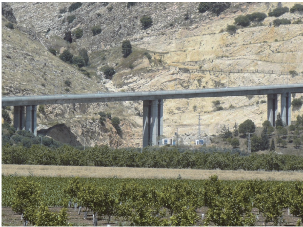
写真 - 12 Quarry Bridge 遠景
