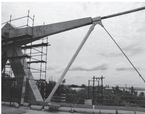
図 - 7 鋼管を用いたハンガーロープ
