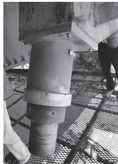
図 - 12 桁下の特殊ねじ部付きの下端ソケット
