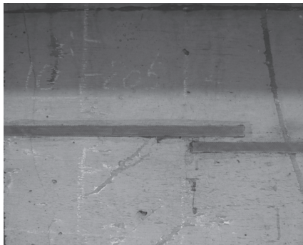
写真 - 5 ひび割れ検知シート設置状況
