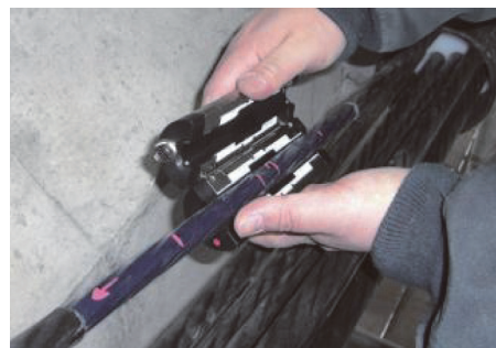
写真 - 4 張力モニタリングセンサー設置状況
