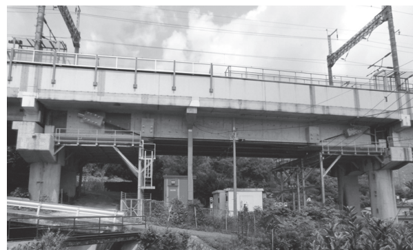
写真 - 1 外ケーブルの設置状況
