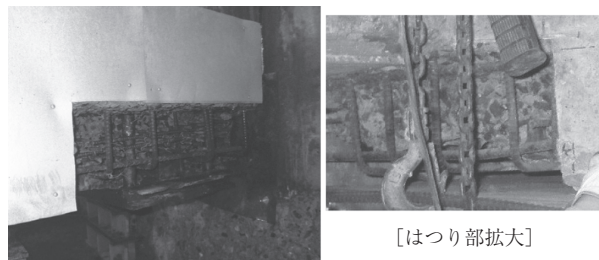
写真 - 15 はつり作業完了
