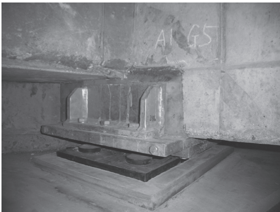
写真 - 16 支取替え完了状況
