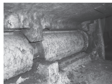
写真-1 鋼製ローラー支承
