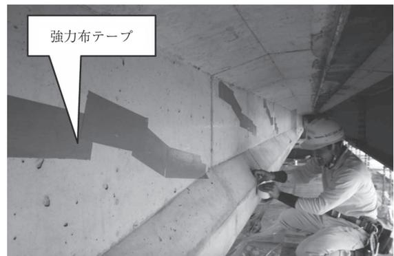
写真 - 4 漏水防止処理実施状況
