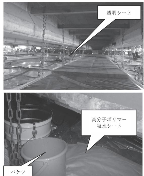
写真 - 5 漏水防止養生
