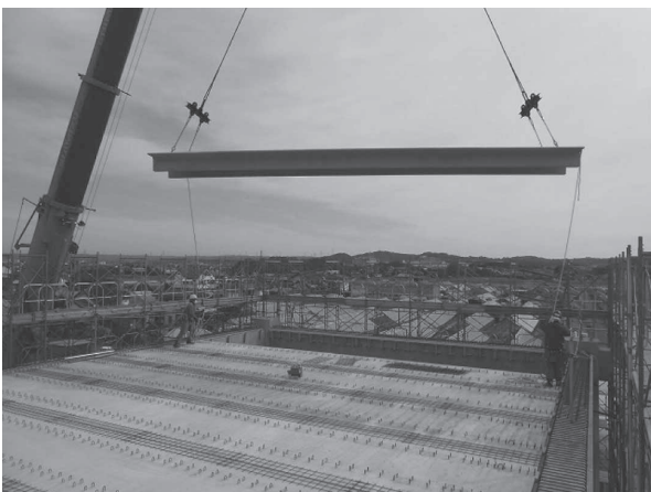
写真 - 10 DT版の架設
