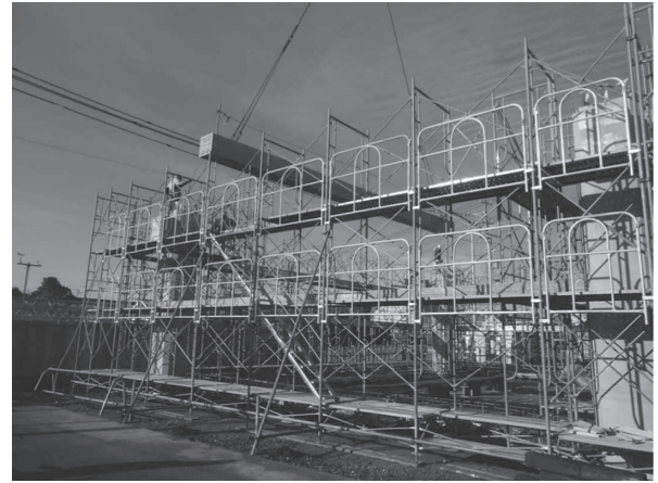
写真 - 6 梁部材の架設
