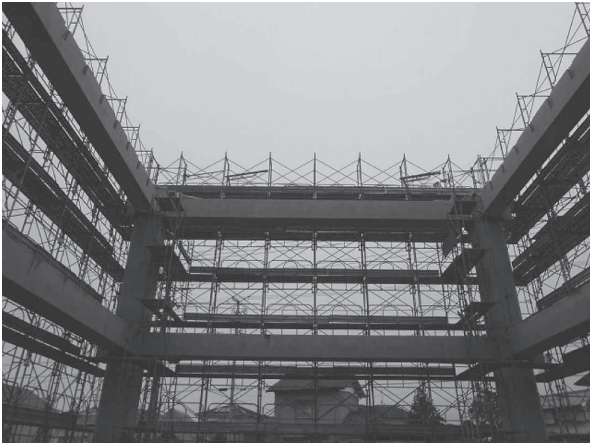
写真 - 9 フレーム完成
