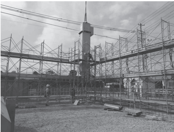
写真 - 5 柱部材の架設
