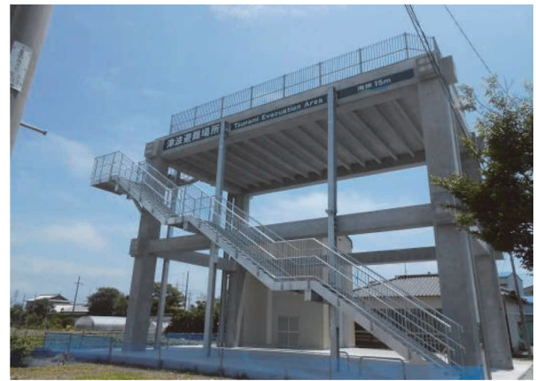
写真 - 2 今沢地区津波避難タワー
