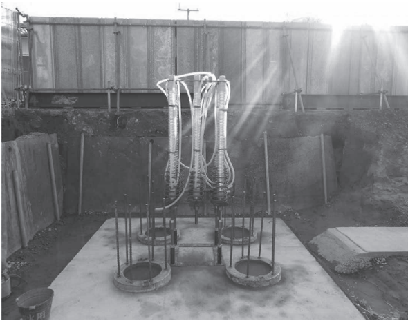
写真 - 4 基礎アンカーフレーム
