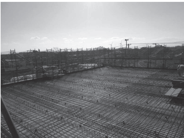
写真 - 11 スラブコンクリートの配筋・打設
