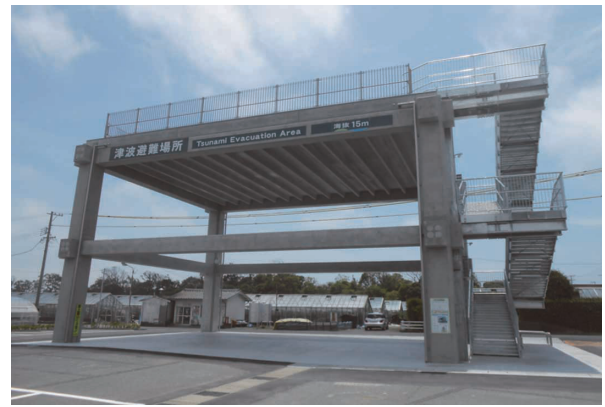
写真 - 1 菊浜地区津波避難タワー
