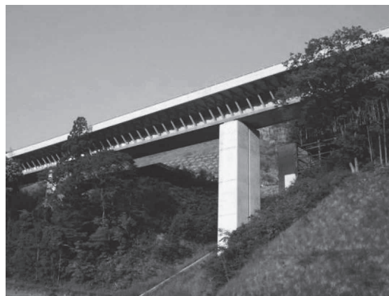
写真 - 8 桂島高架橋
