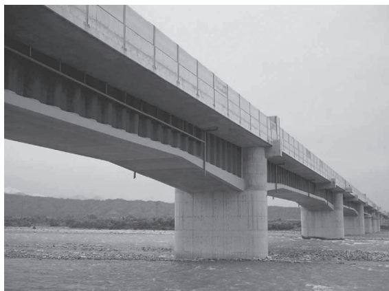
写真 - 6 黒部川橋梁
