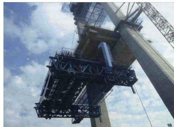
図 - 4 下支え式移動作業車の組立て（Phu My 橋）
