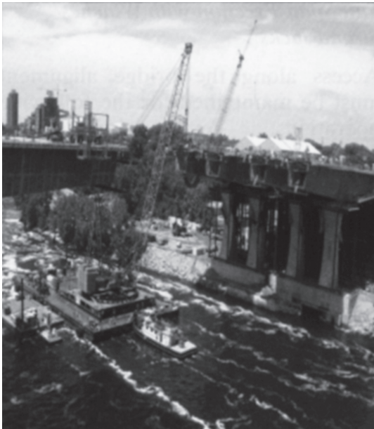
図 - 14 クレーンを用いた張出し架設工法
