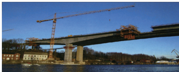
図 - 2 移動支保工（MSS）
