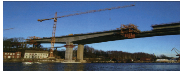
図 - 3 張出し架設工法を用いた Sandesund 橋の施工
