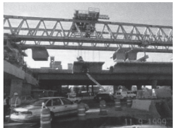
図 - 9 OHG を用いたセグメント架設
