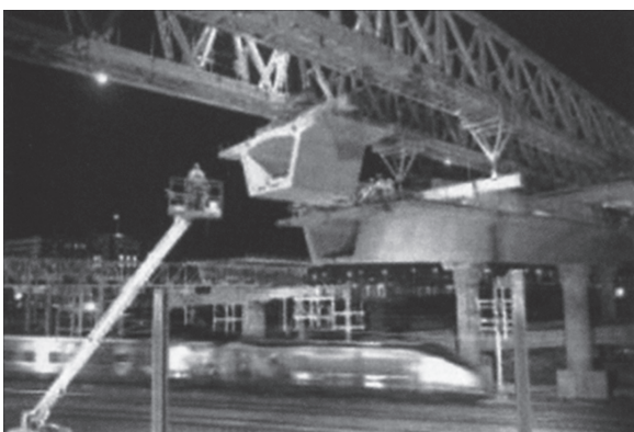
図 - 18 鉄道営業線上での OHG を用いた張出し架設工法
