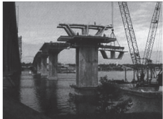
図 - 16 海上クレーンを用いた張出し架設工法
