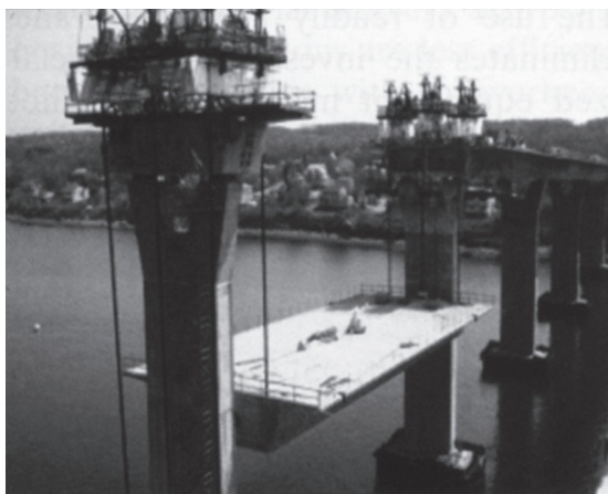
図 - 10 ウインチを用いたフル・スパン架設
