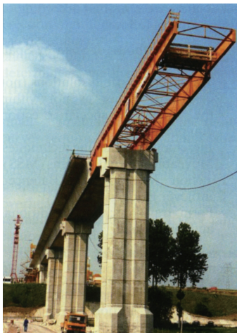
図 - 1 押し出し架設工法と手延べ桁
