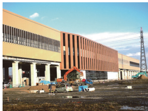
写真-5 新高岡駅の外観
