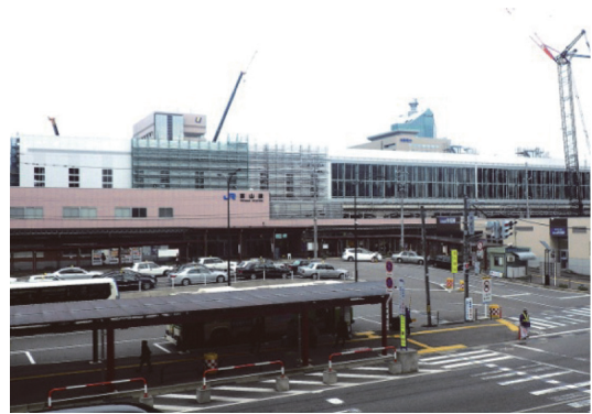
写真-4 富山駅の外観
