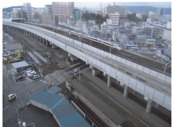
写真 - 2 福井駅付近の高架橋
