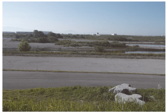
写真 - 1 手取川橋梁予定地
