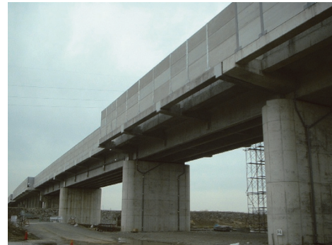
写真 - 3 側方開床桁 (1)
