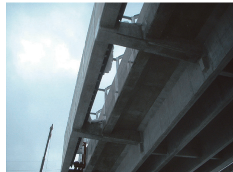
写真 - 4 側方開床桁 (2)
