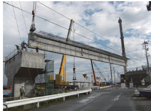
写真 - 6 PC 桁架設
