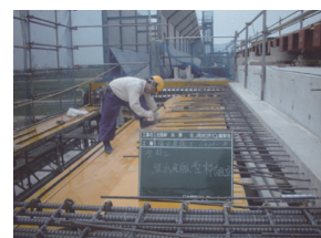
写真 - 1 張出し床版配筋作業
