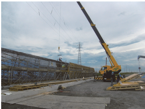
写真 - 5 PC 桁製作
