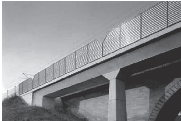
図 - 9 橋脚や橋台と上部工が剛結された Rednitztal 高架橋
