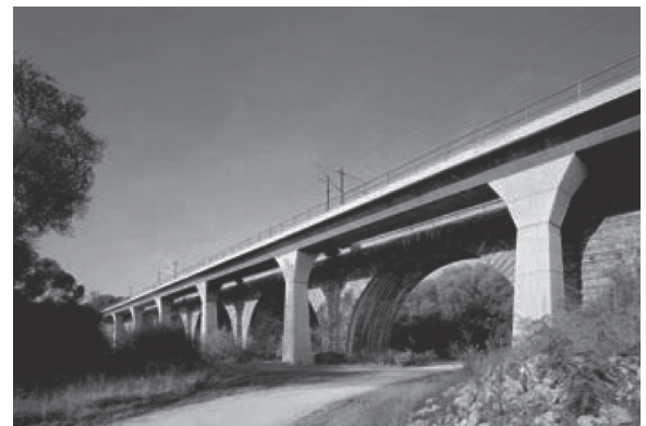
図 - 7 Rednitztal 高架橋の背景の旧橋の石造アーチ橋と前景の RC ラーメン橋構造の新橋の組合せ(石造アーチ橋は建設後 100 年経過し, RC 橋に置き換えられている)
