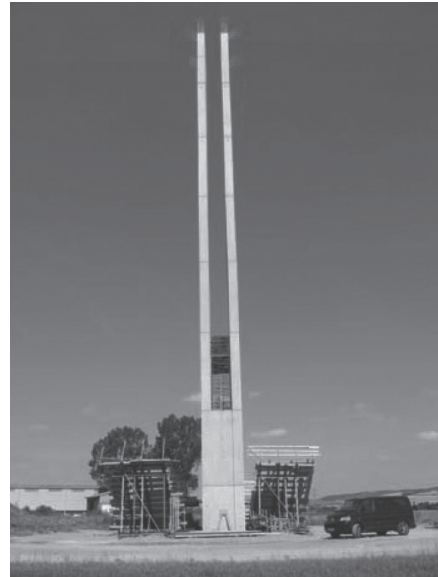
図 - 18 Unstruttal 高架橋の橋脚断面
