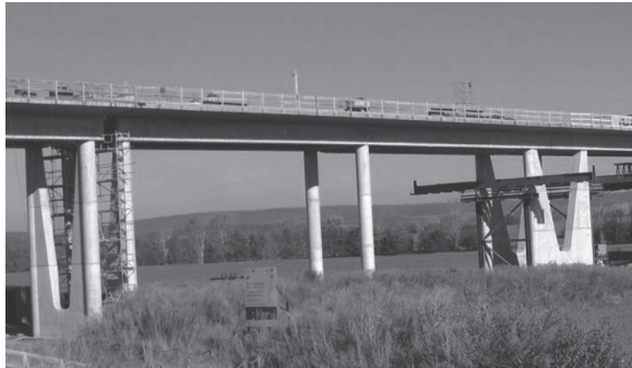
図 - 20 水平方向に固定された上部構造
