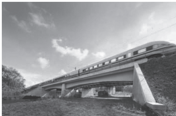
図 - 13 ザーレ川に架かる 2 径間連続ラーメン橋
