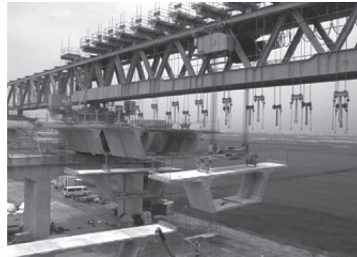
写真 - 5 ハンガータイプによる架設 1)
