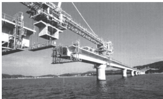
写真 - 7 エレクショントラス架設 1)
