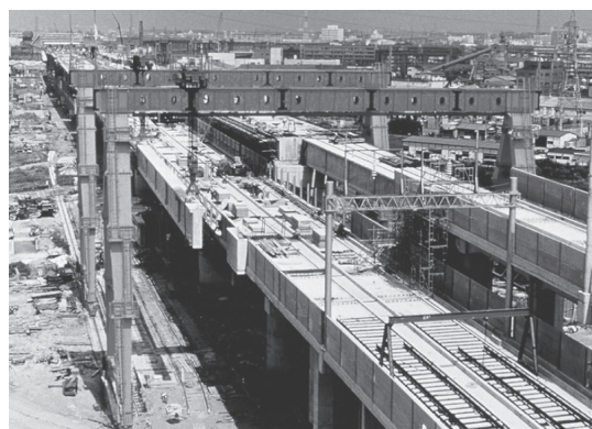
写真 - 4 自走式門形クレーン架設 1)
