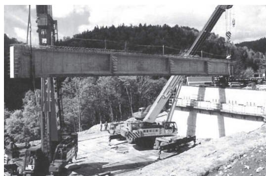
写真 - 3 相吊り架設 1)
