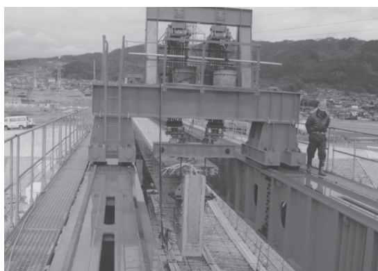
写真 - 2 抱込み式架設 1)
