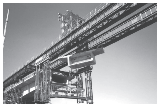
写真 - 6 エレクションガーダー架設 1)
