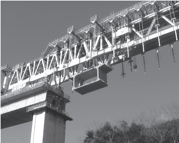
写真 - 9 閉断面箱桁コア断面の架設 1)
