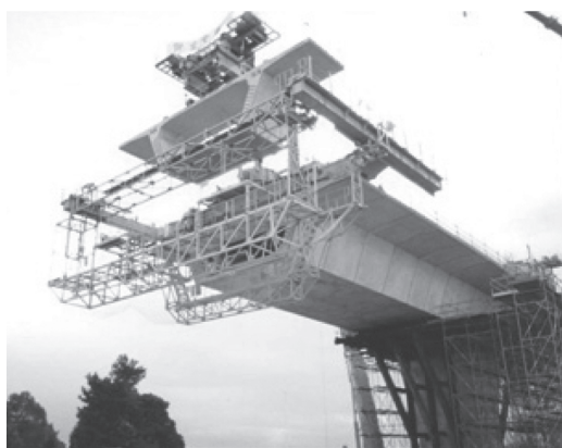
写真 - 8 エレクションノーズ架設 1)
