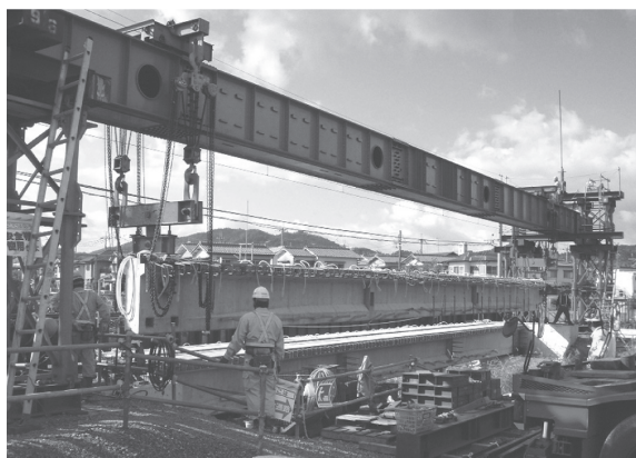
写真 - 1 吊下げ式架設 1)
