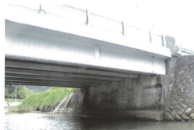
写真 - 2 橋台・桁下状況
