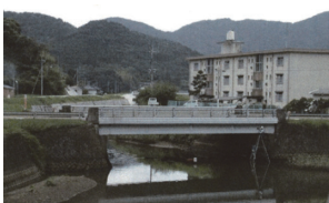
写真 - 1 橋梁側面
