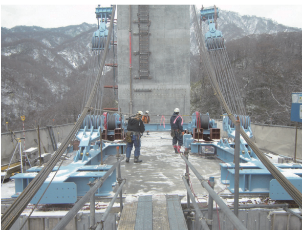
写真 - 7 2次ロアリング施工状況
