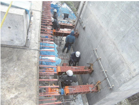
写真 - 6 1次ロアリング施工状況
