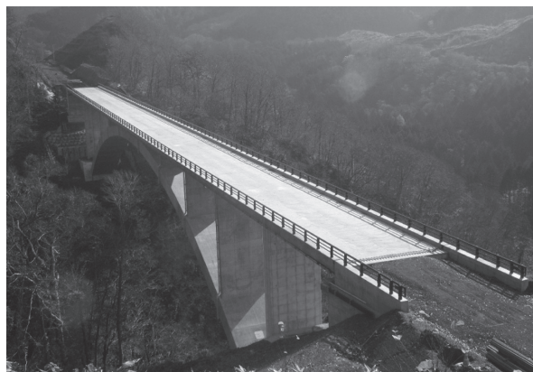
写真 - 1 完成写真
