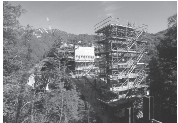
写真 - 13 鉛直材施工
