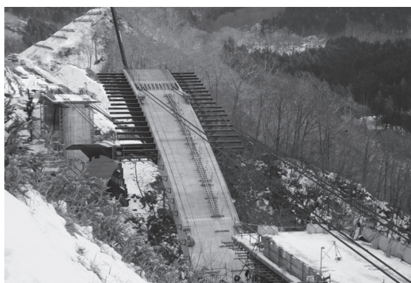
写真-9 4次ロアリング施工状況
