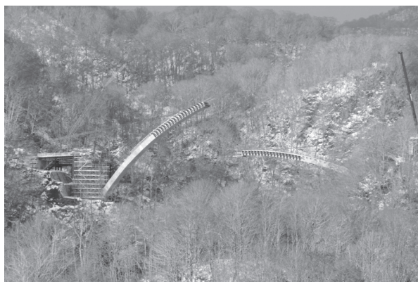
写真-10 4次ロアリング施工状況
