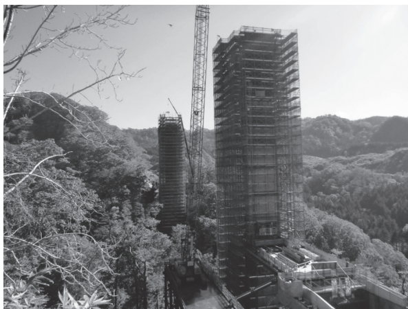
写真 - 4 足場組立て完了全景
