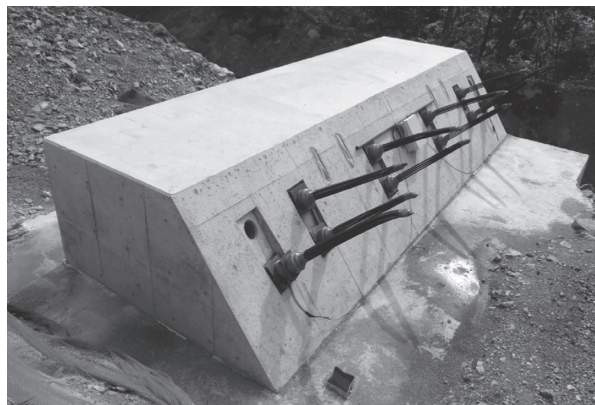
写真 - 5 グラウンドアンカー施工完了
