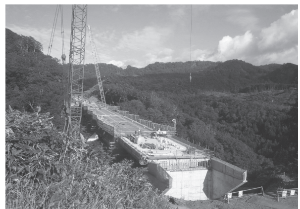
写真 - 14 アーチリブ上の補剛桁施工
